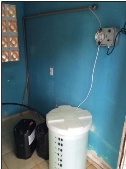
Figura 16. Sistema de desinfecção de poços do SAA de Lucas do Rio Verde: 2015 PT-05: PT-10:
