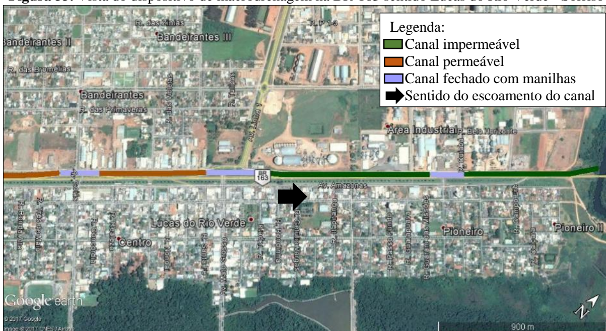
Figura 33. Vista do dispositivo de macrodrenagem na BR-163 sentido Lucas do Rio Verde - Sorriso
