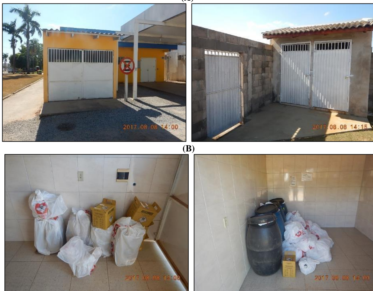
Figura 63. (A) Abrigo para armazenagem de resíduos de serviço de saúde (B) Acondicionamento dos RSS dentro dos abrigos
