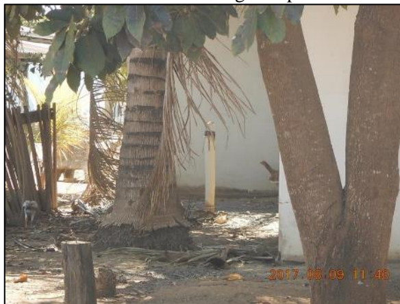
Figura 87. Vista exterior de fossa negra implantada na comunidade
