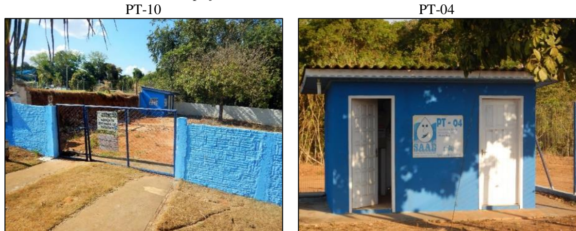
Figura 8. Tipologia padrão das medidas de isolamento e dos abrigos de alvenaria existentes na área dos poços do SAA de Lucas do Rio Verde
