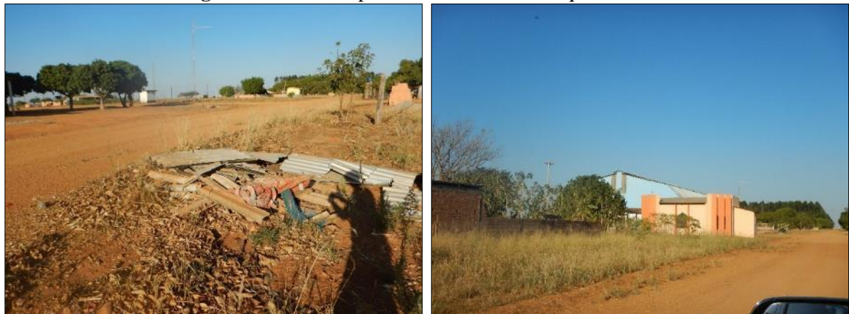
Figura 82. Vias não pavimentadas em Itambiquara - MT
