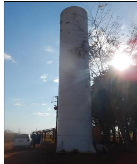
Figura 18. Reservatórios de distribuição de água do SAA de Lucas do Rio Verde (RAP-07 e REL-30)
