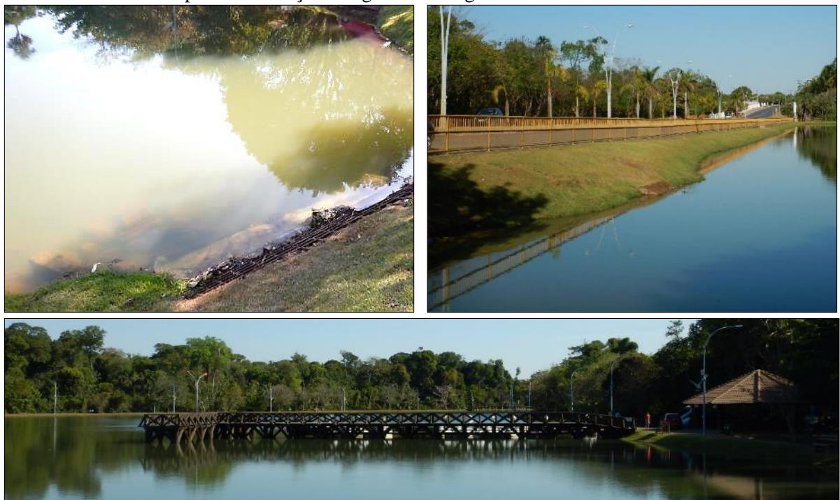
Figura 39. Vista do gradeamento do bueiro de travessia da Av. Tocantins e da barragem construída para acumulação de água do córrego Lucas do Rio Verde
