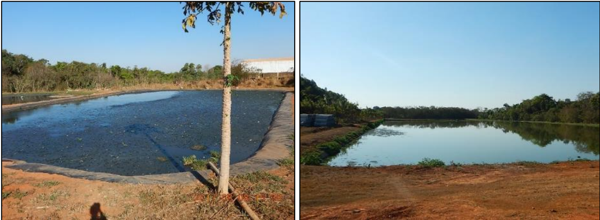
Figura 30. Lagoas anaeróbia e facultativa, respectivamente
