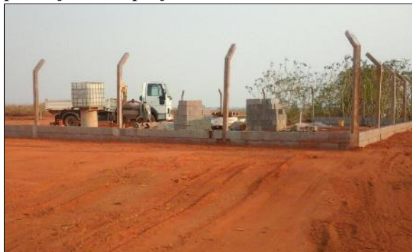
Figura 79. Obra de implantação da captação do sistema de abastecimento de água, Itambiquara
