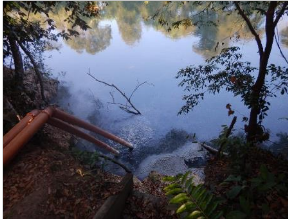
Figura 32. Ponto de despejo do efluente tratado das ETEs UASB e MBBR
