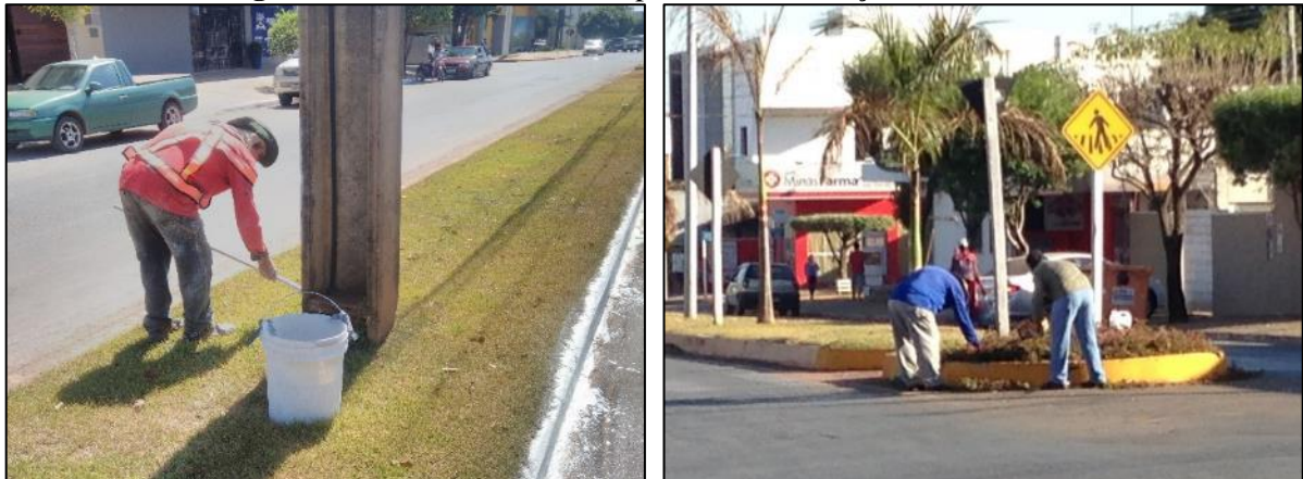
Figura 58. Pintura de meio-fio, postes e manutenção dos canteiros
