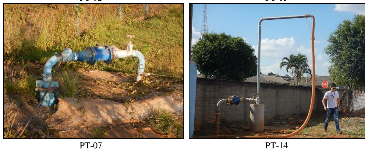
Figura 9. Poços que bombeiam água diretamente na rede de distribuição de Lucas do Rio Verde
