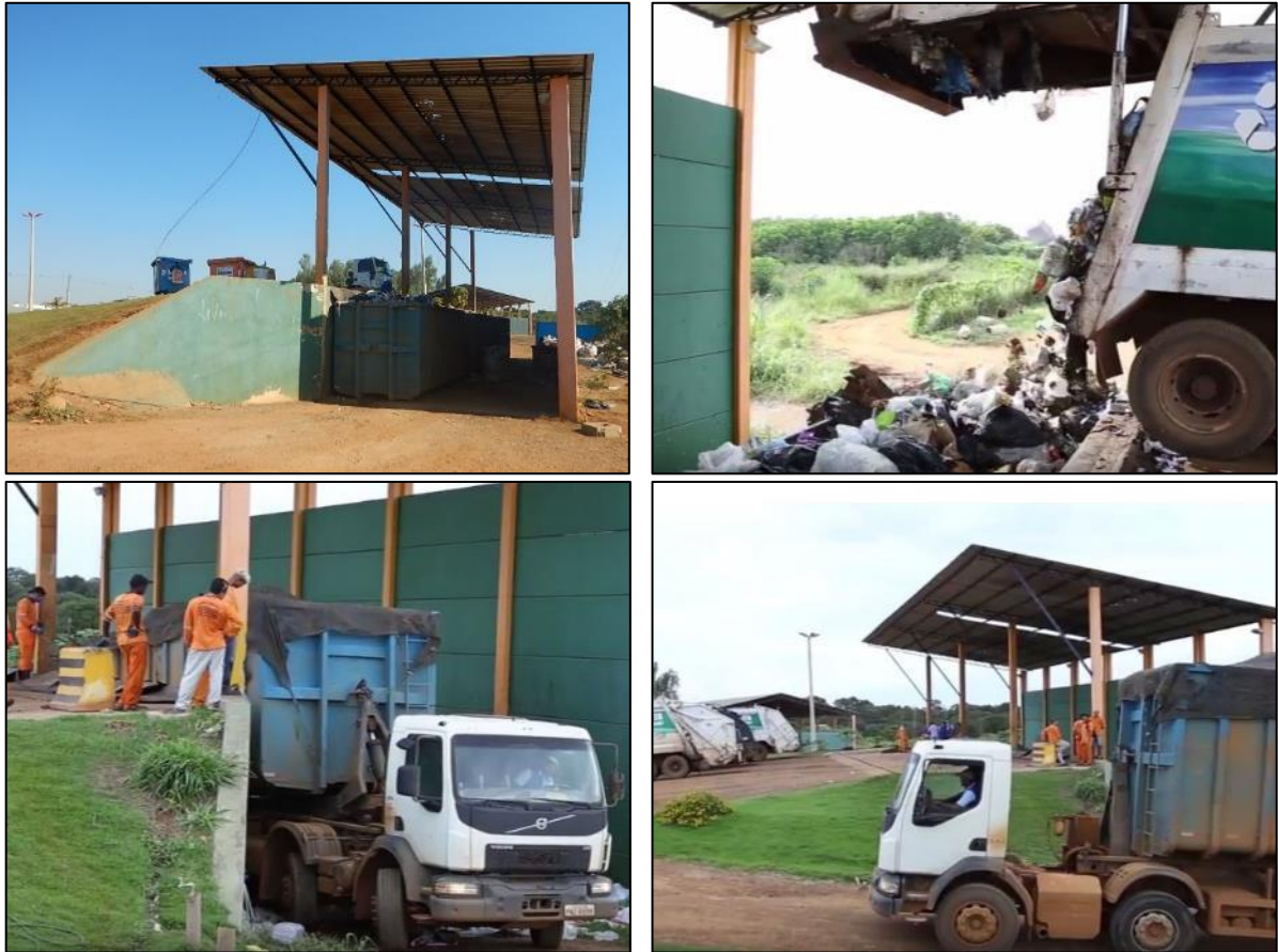
Figura 54. Estação de transbordo e caminhões de transporte de resíduos
