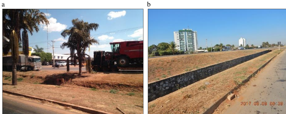
Figura 34. Vista do canal permeável (a) e canal impermeável (b) ao longo da BR-163
