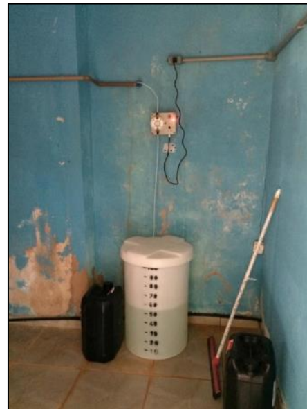
Figura 16. Sistema de desinfecção de poços do SAA de Lucas do Rio Verde: 2015 PT-05: PT-10:
