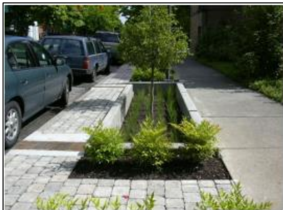
Figura 27. Trincheira de infiltração no passeio
