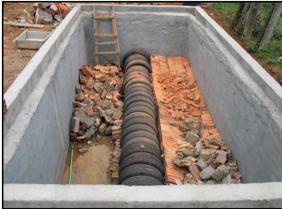
Figura 15. Método do círculo de bananeiras em execução para tratamento individual
