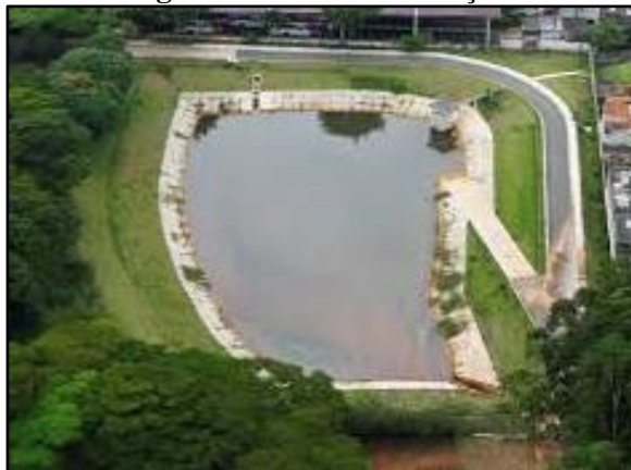
Figura 31. Bacia de detenção
