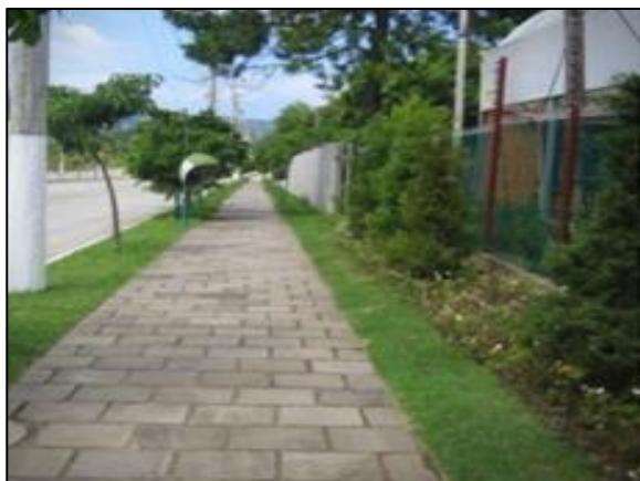
Figura 29. Vala de retenção ao longo da rua
