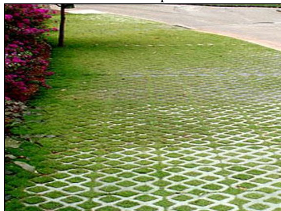
Figura 24. Pavimento poroso – concregrama instalado em passeio
