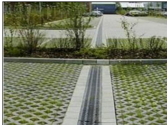
Figura 28. Trincheira de infiltração no estacionamento
