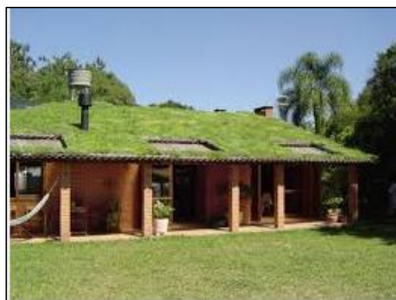
Figura 22. Telhado verde com plantas
