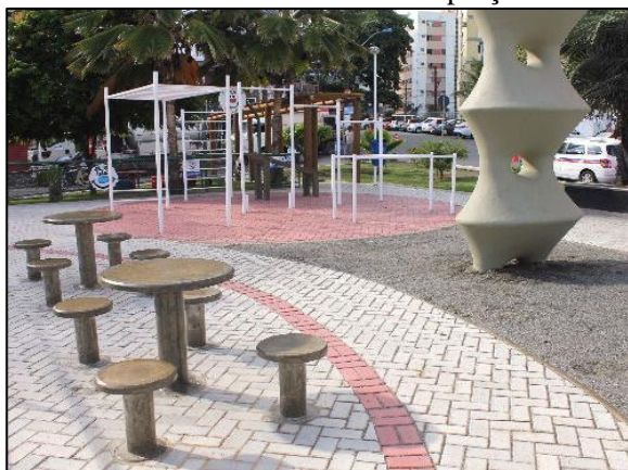
Figura 23. Pavimento poroso – piso intertravado instalado em praça
